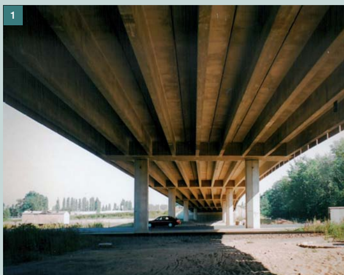
Obr. 1 Estakáda na závodisti v Pardubicích
