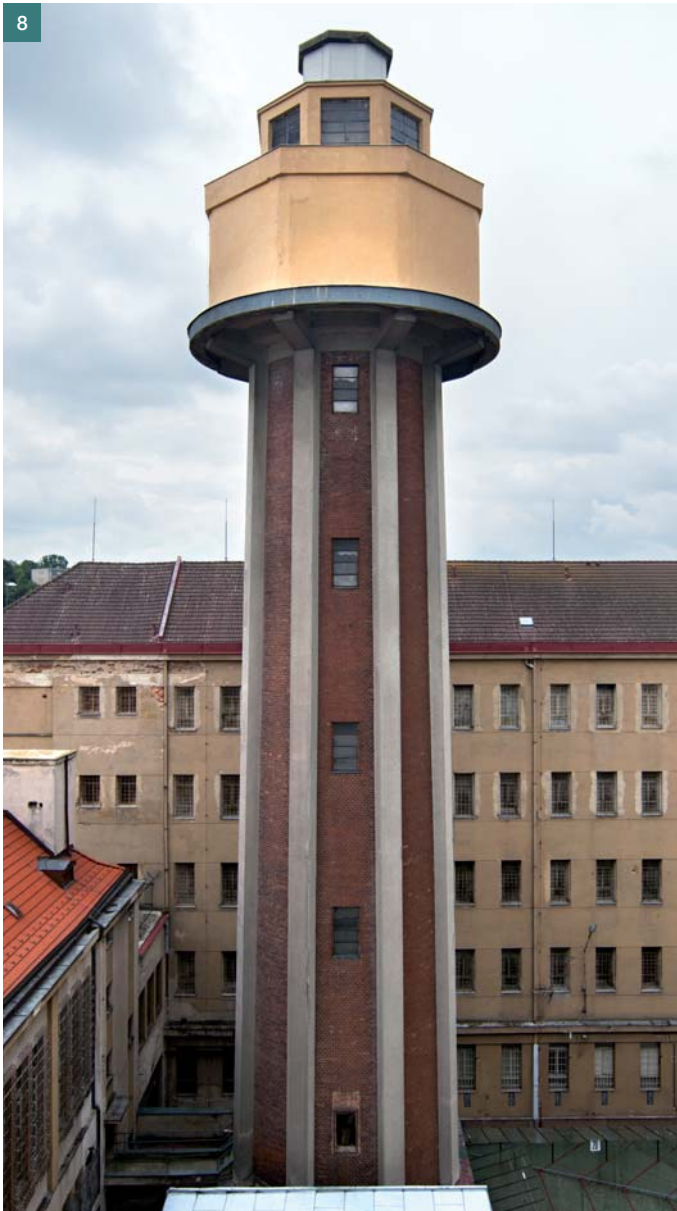
Obr. 8 Komín doplněný o vodojem – Vazební věznice Praha–Ruzyně
