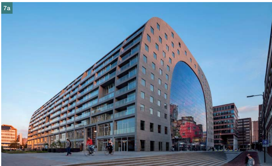
Obr. 7a, b Dokončená stavba ■ Fig. 7a, b Finished construction
