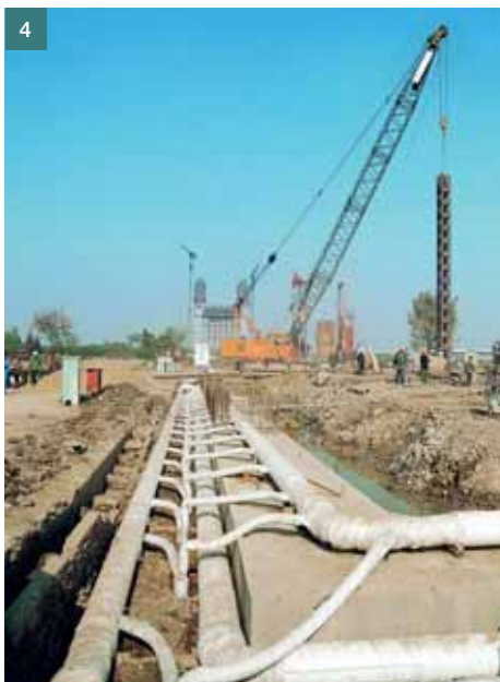
Obr. 4 Instalace zmrazovacích trubek a vertikálního opěrného systému Fig. 4 Installation of freezing pipes (frigoes) and vertical supporting system
