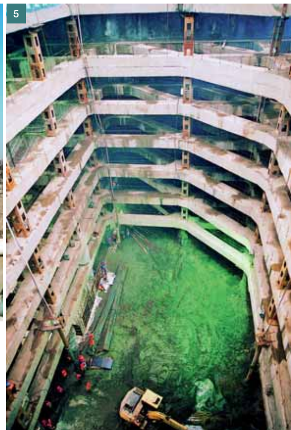
Obr. 4 Instalace zmrazovacích trubek a vertikálního opěrného systému Fig. 4 Installation of freezing pipes (frigoes) and vertical supporting system
