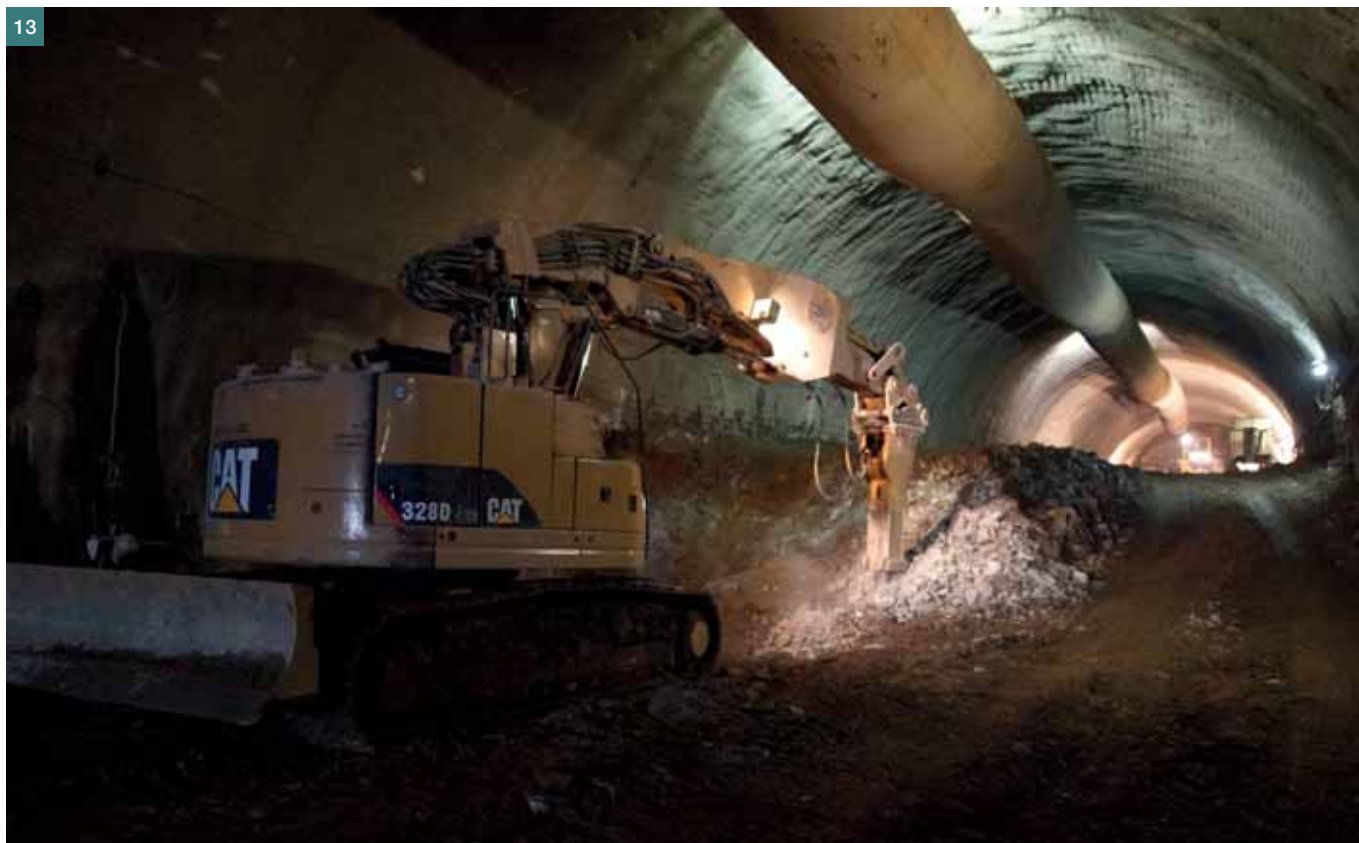
Obr. 13 Horizontální členění výrubu ■ Fig. 13 Horizontal sequencing of the ground loss
