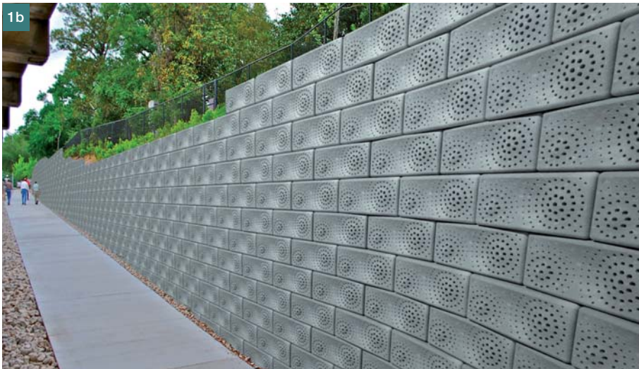
Obr. 1 Betonový hotel pro hmyz, a) betonový blok s otvory, b) příklad použití (vizualizace) ■ Fig. 1 Concrete hotel for insects, a) concrete block with holes, b) how to use it (visualization)
