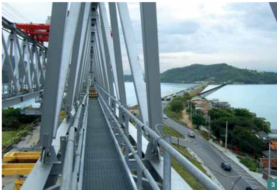
Obr. 3 Pohled ze skruže směrem k stávajícímu silničnímu náspu a železničnímu mostu ■ Fig. 3 View from the gantry, showing the existing road embankment and rail bridge
