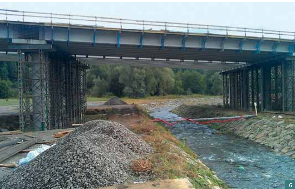
Obr. 6 Výstavba nosnej koňštrukcie ■
