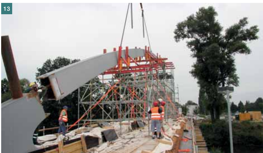
Obr. 13 Montáž oblouků ■ Fig. 13 Arch erection
