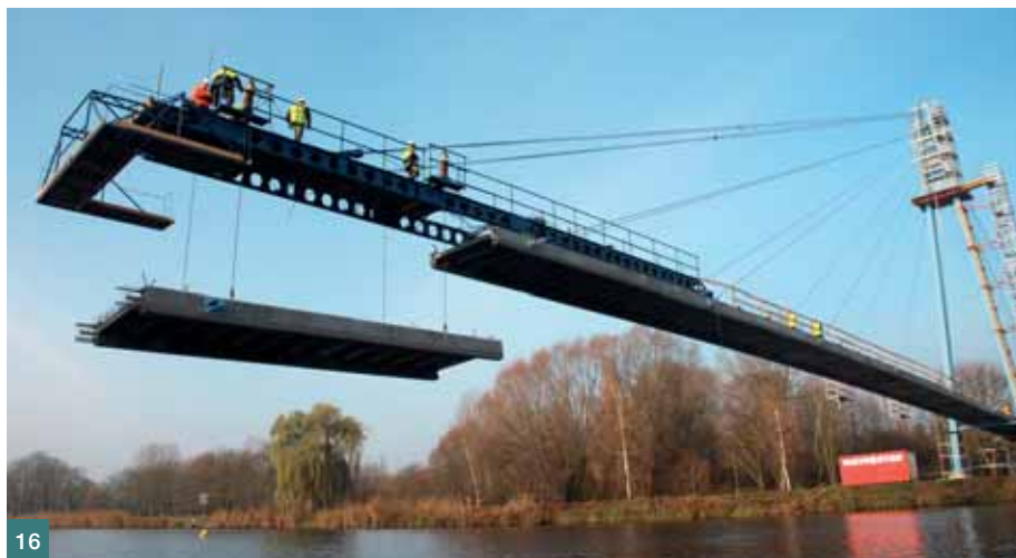
Obr. 16 Zvedání standardního segmentu ■ Fig. 16 Lifting of the standard segment
