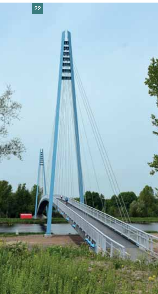
Obr. 22 Dokončená lávka ■ Fig. 22 Completed footbridge
