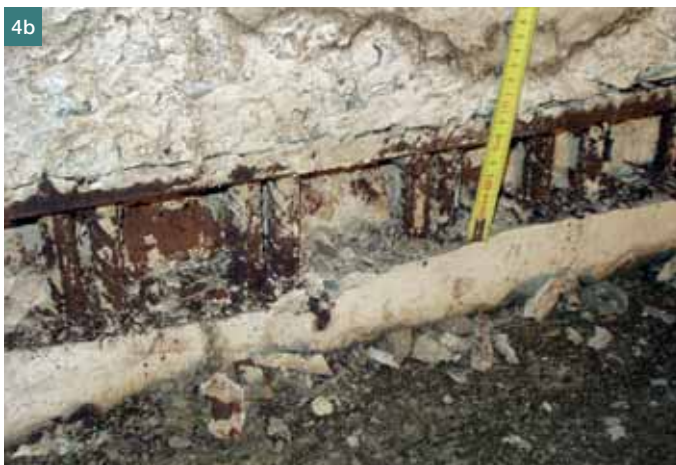
Obr. 4 Ukázky někdy neočekávaných zjištění: a) Insteg výztuž v místě, kde byla předpokládána hladká výztuž jiným rozměru a množství, b) nedostatečné zhuštění betonové desky, c) neplánovaný odvod kouře a ohořelý spodní líc desky uvnitř komůrky mostu, d) ponechané bednění v komůrce mostu, s kolečkem plným zatvrdlého betonu, nářadí... ■ Fig. 4 Examples of sometimes unexpected findings: a) Insteg reinforcement, where smooth reinforcement of different size and amount was expected, b) insufficient compacting of the concrete slab, c) not expected smoke outlet and burnt bottom side of the slab inside the bridge chamber, d) left formwork inside the bridge chamber, with a wheelbarrow, tools ...
