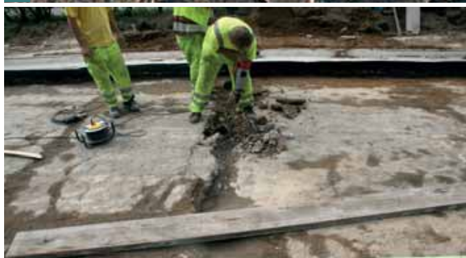
Obr. 28 Vystřelení desky ve zpevněné krajnici 2. července 2012, viditelná je alkalická reakce v betonu ASR (trhliny s tmavým lemováním – charakteristický příznak škodlivé rozpínavé reakce v betonu) ■ Fig. 28 Shot-out of the slab in the hard shoulder on July 2, 2012, visible alkali reaction of concrete (failures with dark flanges – typical sign of damaging expansion reaction)
