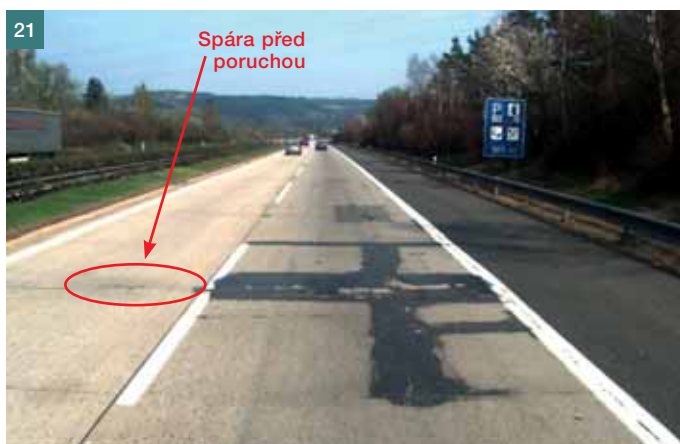
Obr. 21 Místo poruchy CB kryty vozovky na dálnici D1, před událostí ■ Fig. 21 The failure point of the cement-concrete road surface on D1, before the accident
