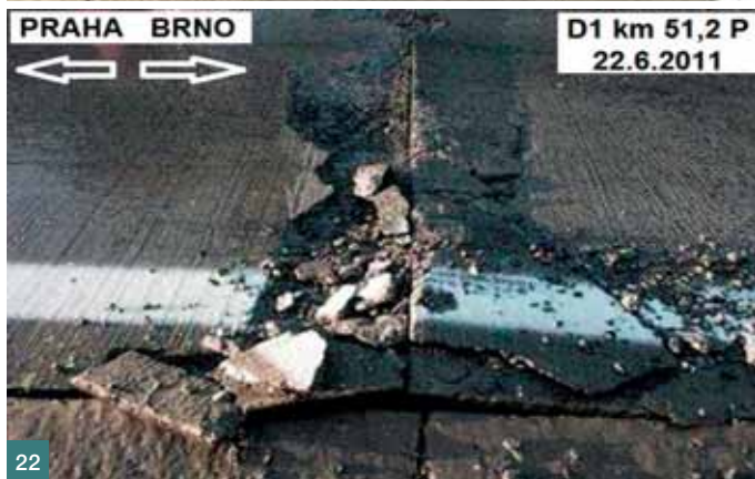
Obr. 25 Porucha v rychlém JP je v místě oslabení pomalého JP nevhodnou opravou z asfaltové směsi ■ Fig. 25 Failure in the fast lane is in the place of weakening of the slow lane inappropriate repair from tar mixture
