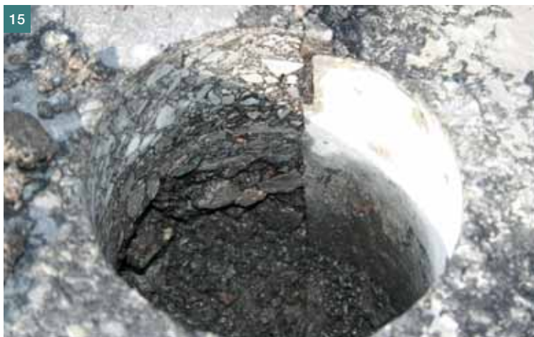
Obr. 15 Vývrt dilatační spáry ve vozovce, kde byla zjištěna absence původně navržené stlačitelné vložky na kontaktu cementový beton-asfalt vedle hrbolu ■ Fig. 15 Core of the dilatation joint in the road surface where was also found absence of the initially designed compressive inlays on the spot of contact between cement-tar next to the bump
