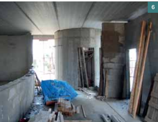
Obr. 4 Betonové tvarovky sloužící jako ztracené bednění ■ Fig. 4 Concrete filler blocks serving as permanent formwork
