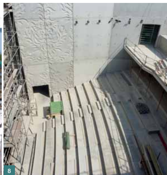
Obr. 7 Osazování prefabrikovaných panelů, betonáž vnitřních stěn ■ Fig. 7 Mounting the precast concrete panels, concreting of the internal walls
