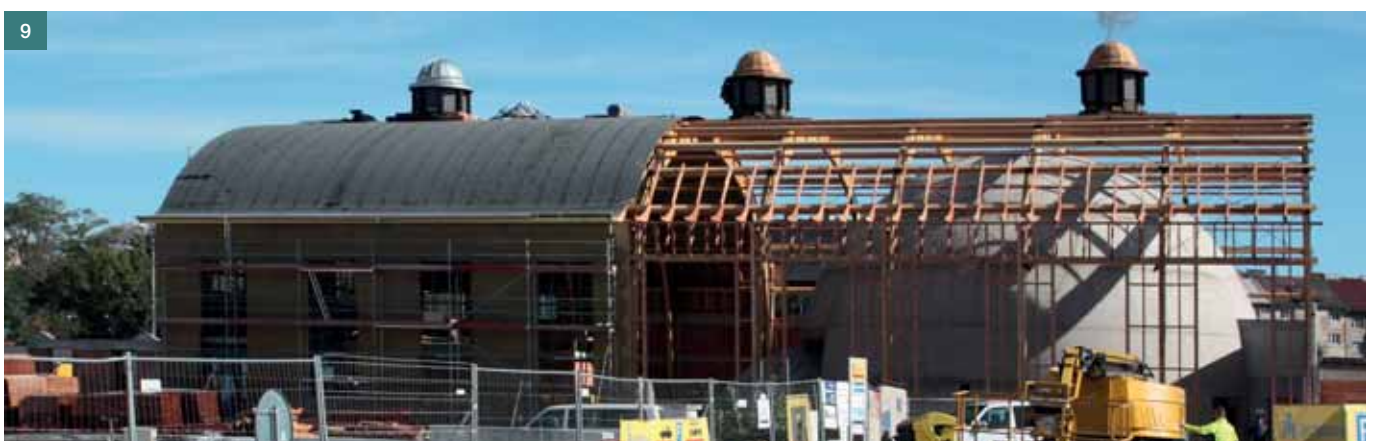
Obr. 9 Budova Planetária, z části již opláštěna, v druhé části dřevěné lepené vazníky tzv. Hetzerovy konstrukce nad betonovými kopulemi ■ Fig. 9 The Planetarium building partly clad, in the second part wooden glued girders of the so called Hetzer's construction above the concrete domes
