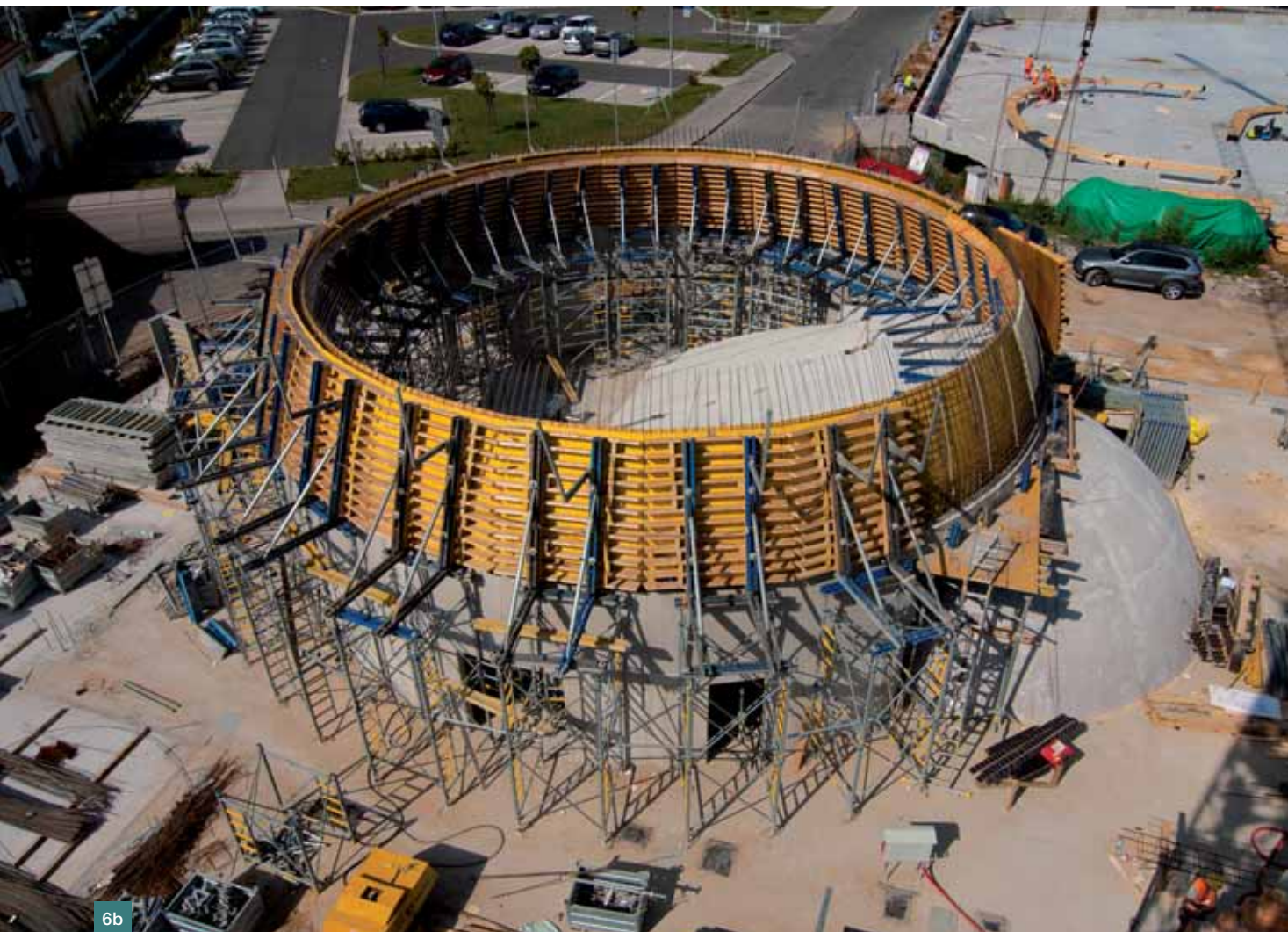
Obr. 5a, b Bednění malé kopule ■ Fig. 5a, b Formworks of the small dome
