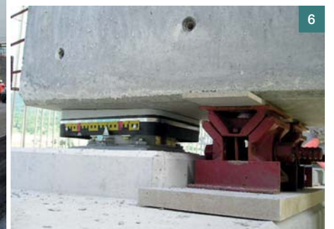
Obr. 6 Detail dočasného a trvalého uložení na opoře ■ Fig. 6 Detail of the temporary and permanent support at abutment
