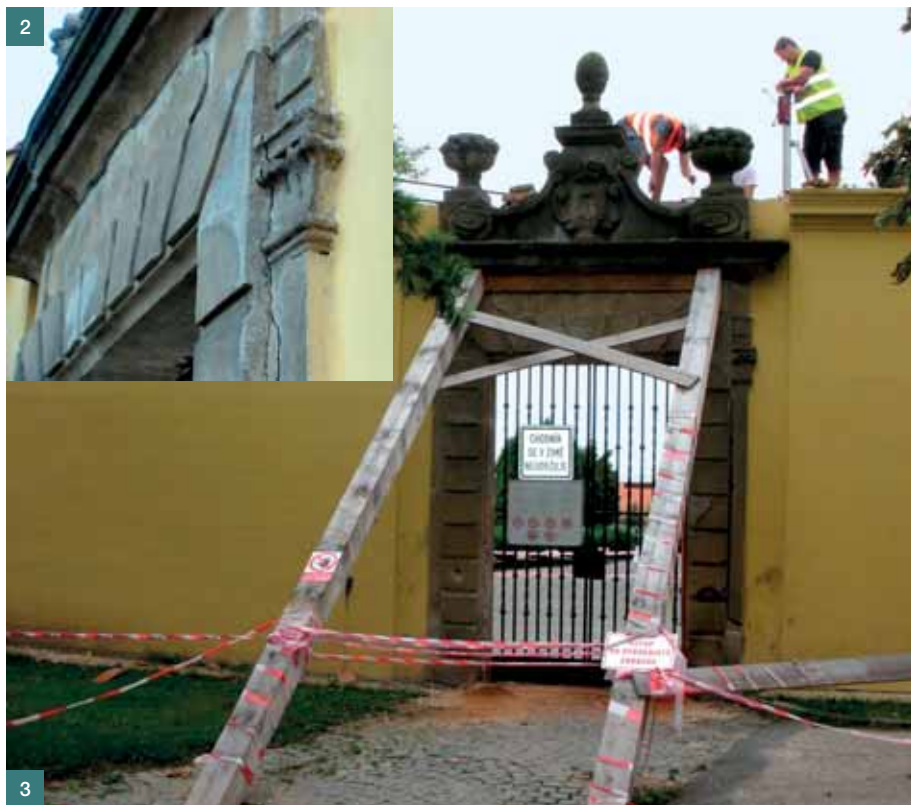
Obr. 1 Vychýlení stěny a provizorní zajištění Fig. 1 Wall deflection and its temporary securing
