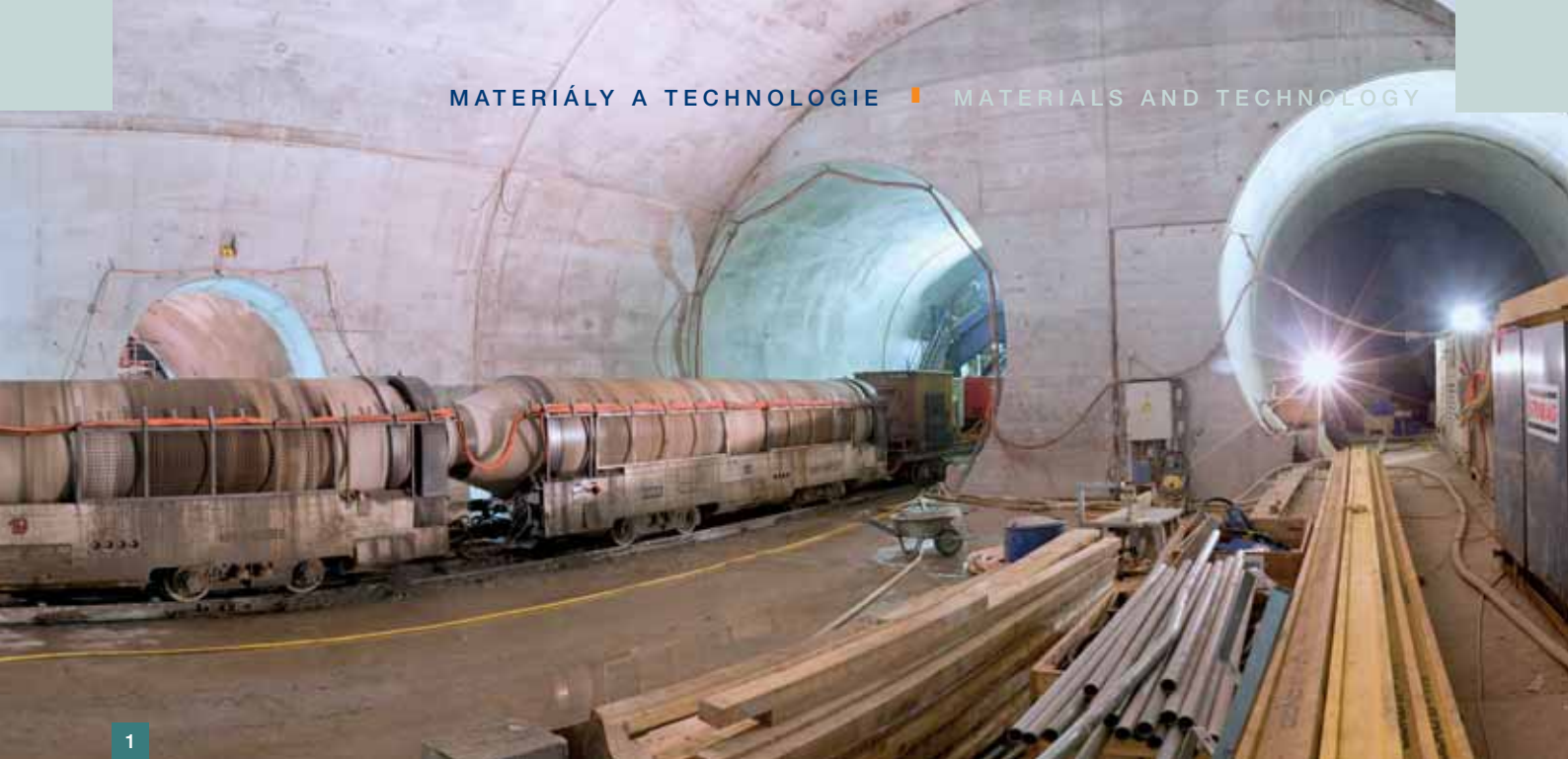
Obr. 1 Bednicí tunelová forma při nasazení na rozpletu tvaru Y v sekci u Erstfeldu Gotthardského tunelu ■ Fig. 1 Moulding tunnel formwork when placed at a Y diversion of the Gotthard Tunnel at the section near Erstfeld
