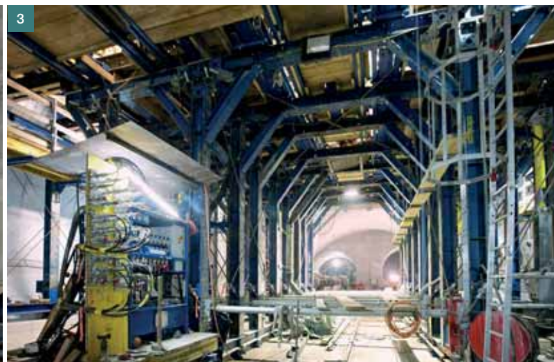
Obr. 5 Příprava výztuže a bednění boční klenby ■ Fig. 5 Preparing the reinforcement of the side vault
