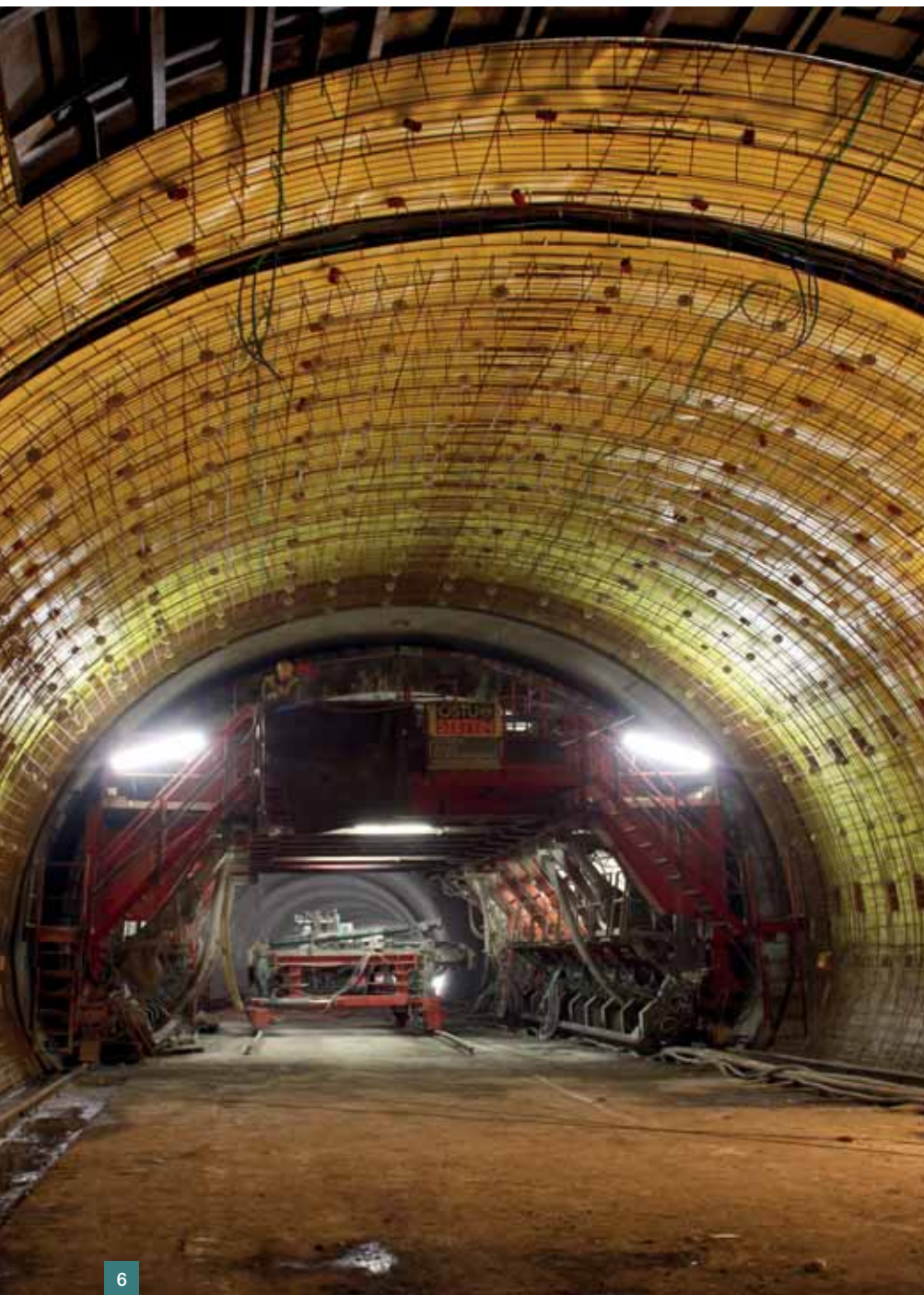
Obr. 6 Armatura klenby dvoupruhového tunelu ■ Fig. 6 Vault reinforcement of two lane tunnel
