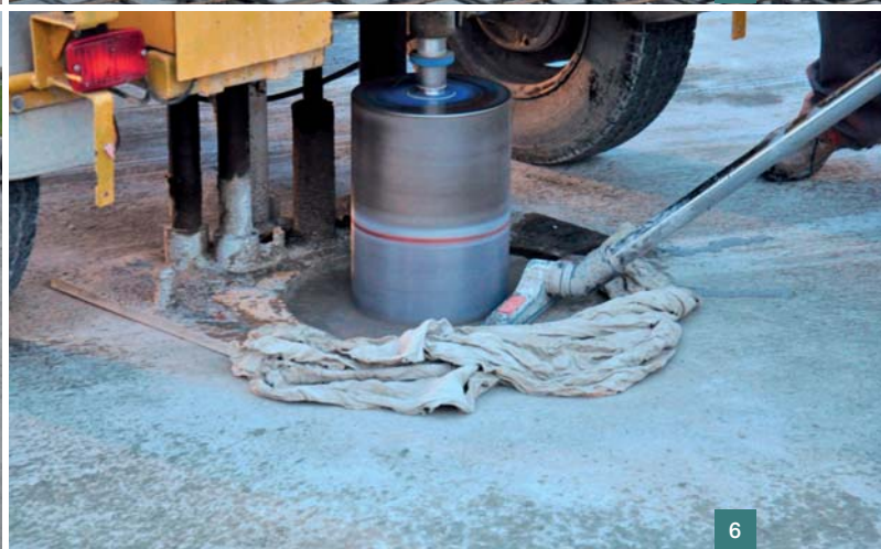
Obr. 3 Bourání staré poškozené betonové desky ■ Fig. 3 Demolition of the damaged old concrete slab
