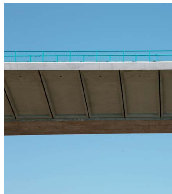
Obr. 22 Prefabrikované vzpěry ■ Fig. 22 Precast struts
