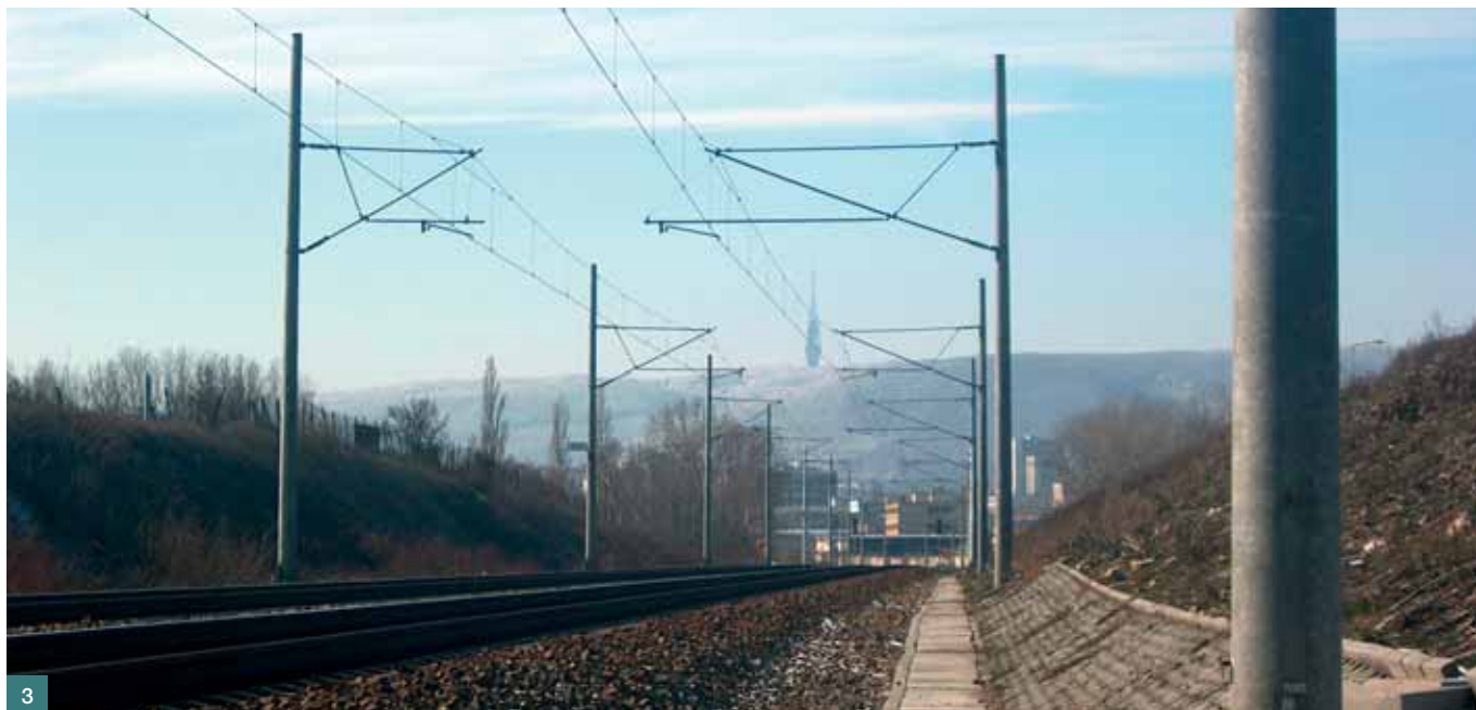
Obr. 3 Použitie stožiarov ako podpier trakčného vedenia železníc ■ Fig. 3 Usage of pylons as traction distribution support for railways
