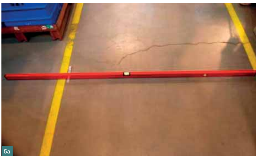
Obr. 5a, b, c Podélné vysychací trhliny ■ Fig. 5a, b, c Longitudinal cracks caused by drying
