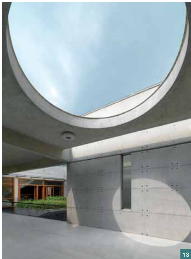
Obr. 13 Kruhový otvor ve střeše „deštného pokoje“ ■ Fig. 13 Circular opening in the roof of the „rain room“
