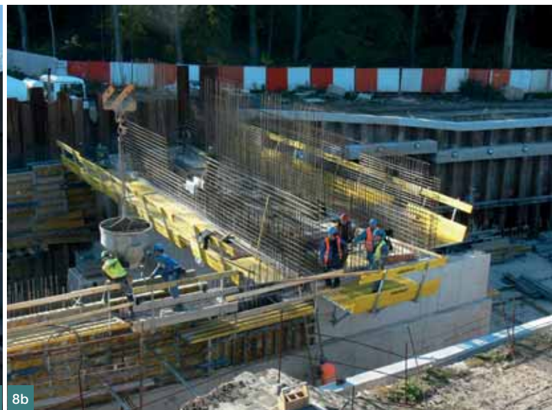
Obr. 8 Betonáž železobetonových konstrukcí, a) betonáž stropu podzemního podlaží, b) betonáž pravé stěny strojovny
