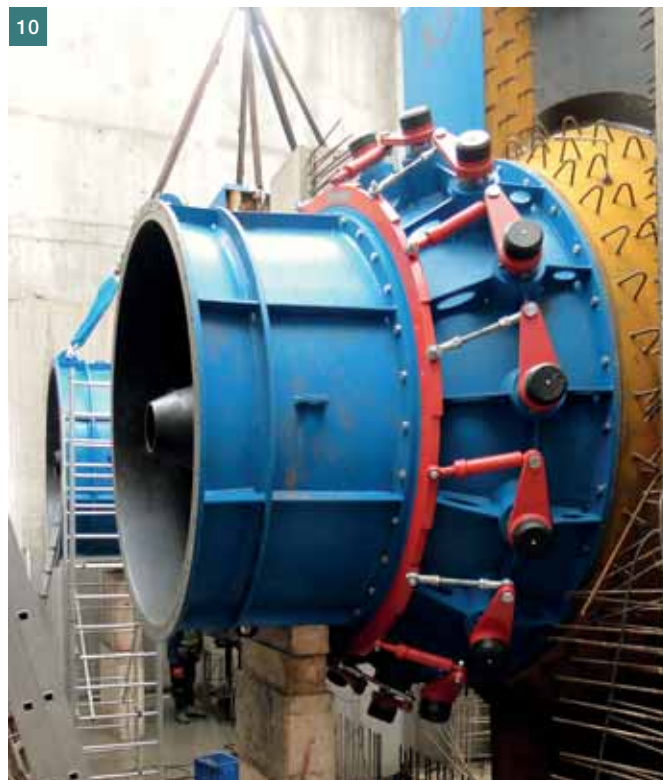
Obr. 11 Montáž bednění pro sekundární betonáže vtoku ■ Fig. 11 Installation of formworks for secondary inlet concreting
