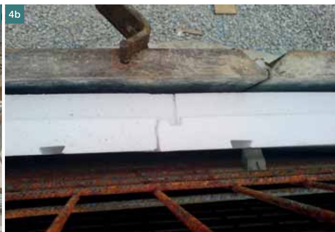
Obr. 4 a) Bednění stěny bioplynové stanice s vloženým extrudovaným polystyrenem, b) detail polystyrenové tabule opatřené speciálními zámky ■ Fig. 4 a) Framework of biogas station wall with inserted extruded polystyrene, b) detail of polystyrene desk equipped with special fastenings
