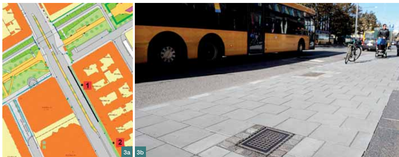
Obr. 3 Ulice Amiralsgatan: a) situace s vyznačením měřících bodů a úseku chodníku opatřeného v první fázi dlažbou s technologií TX Active, b) chodník opatřený dlažbou TX Active (fotografie: Mats Persson) ■ Fig. 3 Amiralsgatan Street, a) situation with marked points and parts of the pavement with the paving with the technology TX Active, b) pavement with the TX Active paving (photo: Mats Persson)
