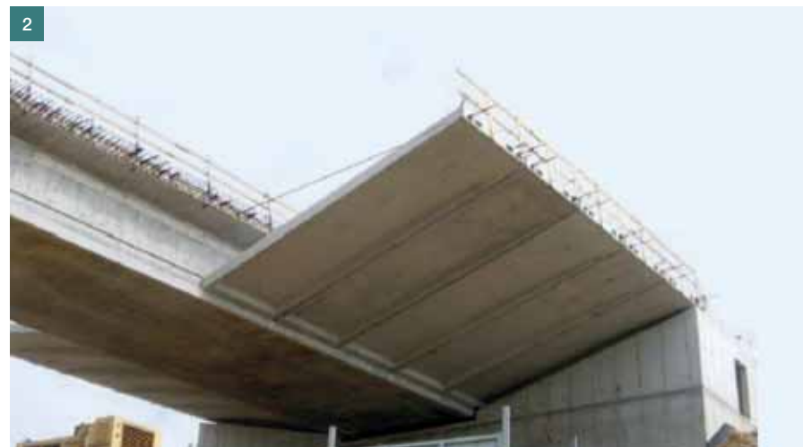
Obr. 2 Osazování vzpěrných prefabrikovaných stěnových prvků, (převzato z [4]); most na R1 nad údolím Hošťovského potoka, nedaleko města Nitra, projekt RDS zpracovala firma SHP ■ Fig. 2 Assembly of precast strut plates (after [4]); the bridge on the R1 over Hostovský creek valley, near the town of Nitra, the project prepared by the firm SHP
