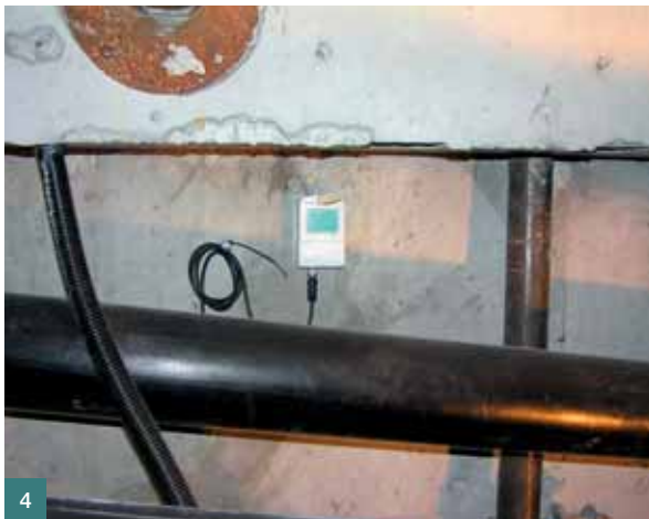
Obr. 4 Měření teploty a vlhkosti vzduchu v dutině mostu ■ Fig. 4 Measurement of air temperature and the humidity in the box of the bridge
