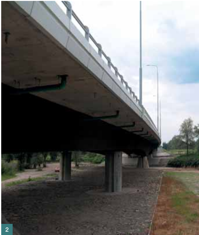
Obr. 2 Pohled na konstrukci mostu přes řeku Ostravici ■ Fig. 2 View of the bridge over the Ostravice River
