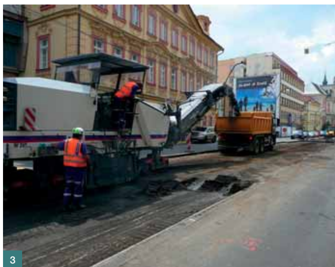
Obr. 1 Odstranění těsnících prvků a stávajících kolejnic ■ Fig. 1 Removal of sealing elements and existing rails
