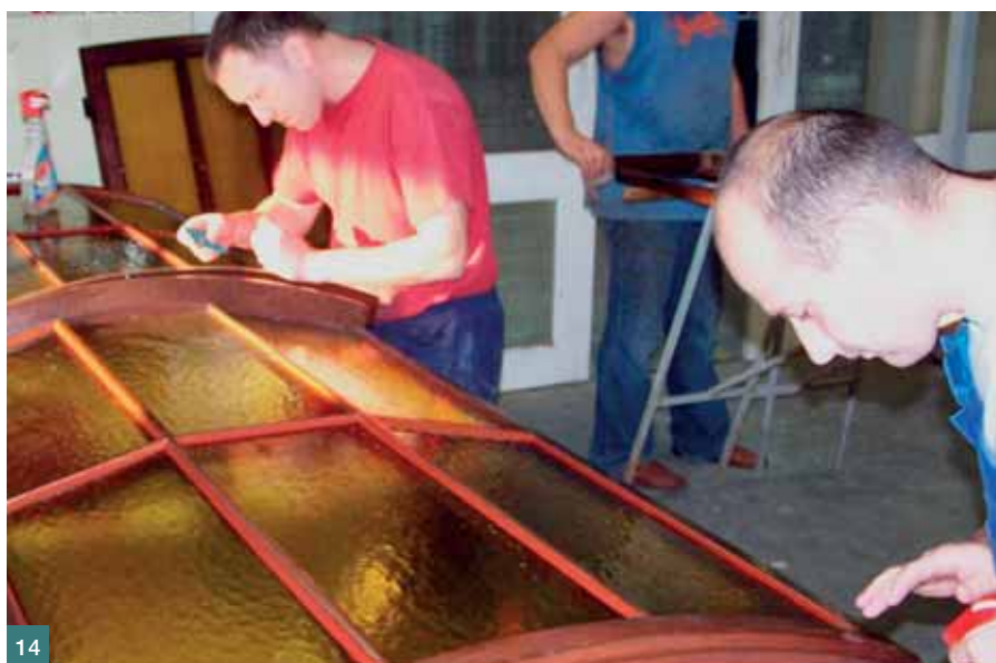
Obr. 14 Zasklívání oken okrovým ornamentálním sklem, vyrobeným podle původního vzorku ■ Fig. 14 Glazing of the windows with ochre ornamental glass produced by an original sample
