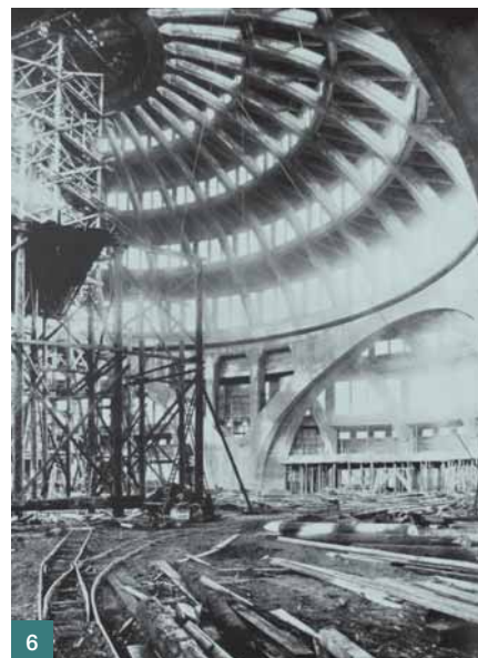
Obr. 5 Lešení, bednění a okenní rámy [2] ■ Fig. 5 Scaffolding, formwork and window frames [2]
