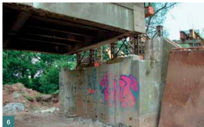
Obr. 6 Zvedání nosné konstrukce ■ Fig. 6 Elevation of the superstructure of the bridge
