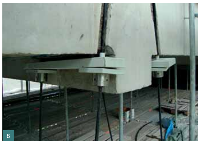
Obr. 9 Zesílení závěsů oblouku – volné kabely monostrand ■ Fig. 9 Reinforcement of the arch ties – external prestressed unbonded cables monostrand
