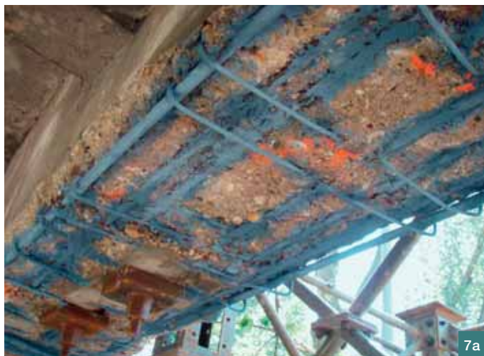
Obr. 7a, b Zesílení a sanace nadpodporových příčníků ■ Fig 7a, b Reinforcement and restoration of the end crossbeams
