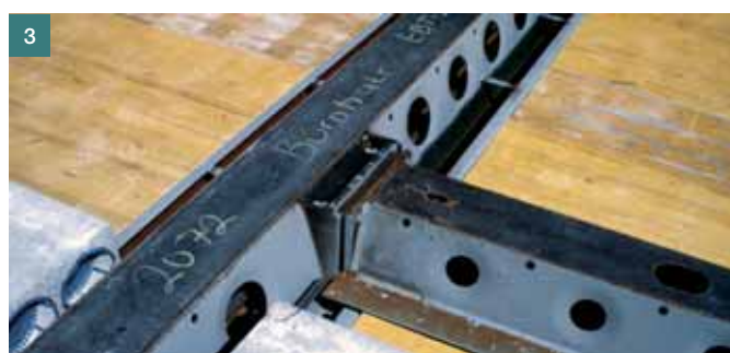
Obr. 1 Delta nosník určený pro spřažení ■ Fig. 1 Deltabeam for composite systems
