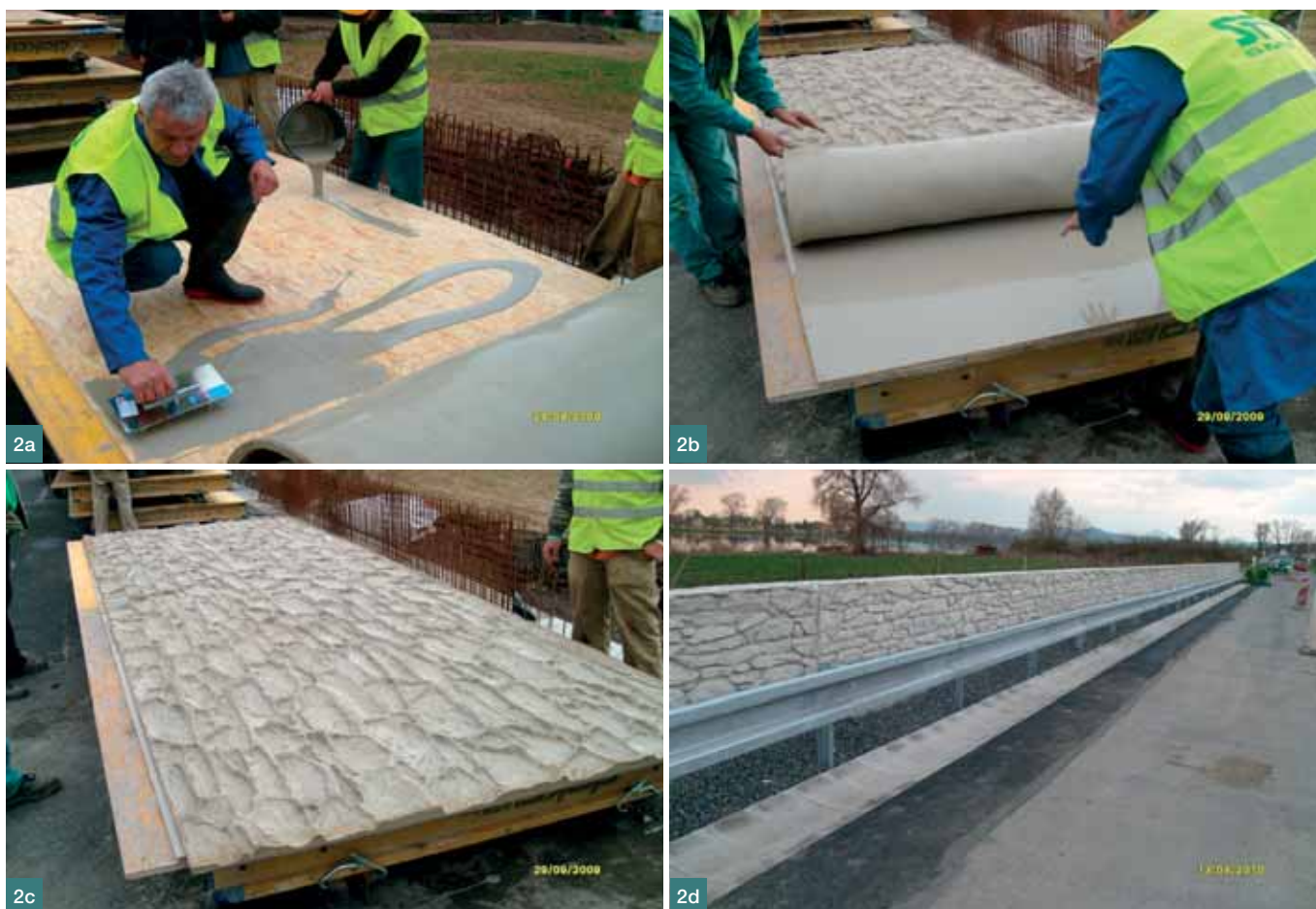
Obr. 2 Užití strukturálních matric pro vytvoření pohledové plochy železobetonové protipovodňové stěny mezi obcemi Křešice a Nučnice na pravém břehu Labe, SMP CZ, a. s., 2010, a) nanášení lepidla na podkladní desku, b) rozvinování matrice na vrstvu lepidla, c) matrice připravená na bednění, d) dokončená železobetonová protipovodňová stěna s otiskem vzoru vyskládaných kamenů ■ Fig. 2 Application of structural matrix for exposed concrete surface of flood protection wall between villages Křešice and Nučnice on the right bank of the river Labe, SMP CZ, 2010
