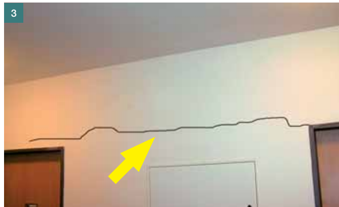
Obr. 1 Charakteristické trhliny ve stěně z vápenopiskových bloků u lázeňského bytového domu ■ Fig. 1 Characteristic cracks in the wall made of lime-sand units used in a bath and residential house
