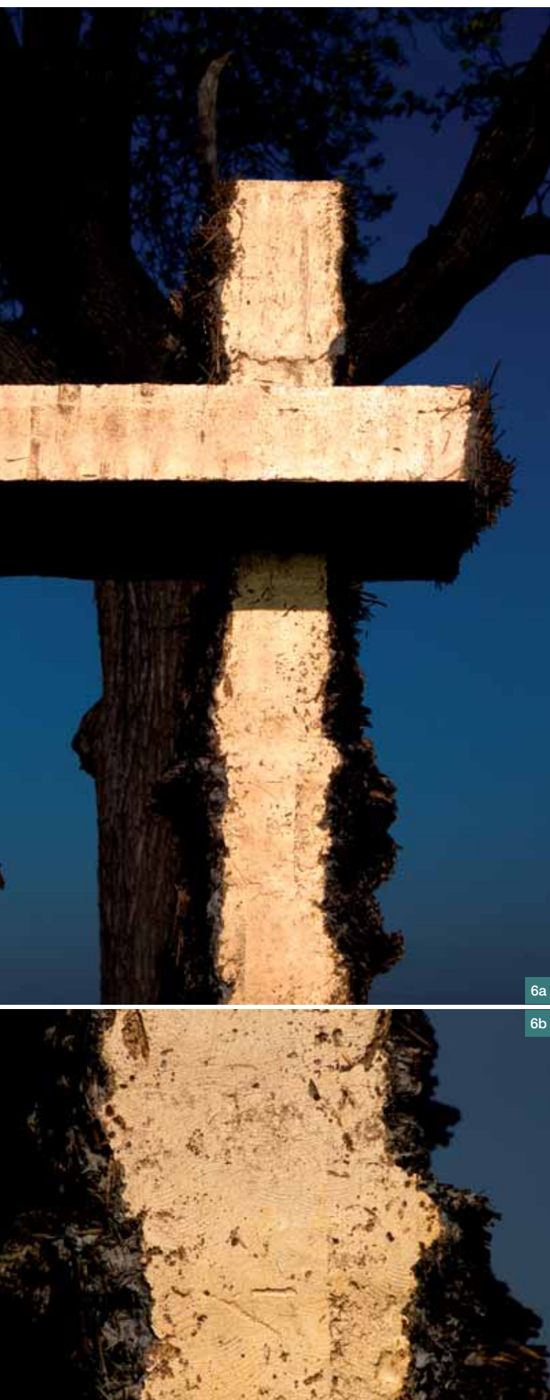
Obr. 6 a) Pozlacený betonový kříž, b) detail zlaceného betonového povrchu ■ Fig. 6 a) Gold-plated concrete cross, b) detail of the golden concrete surface
