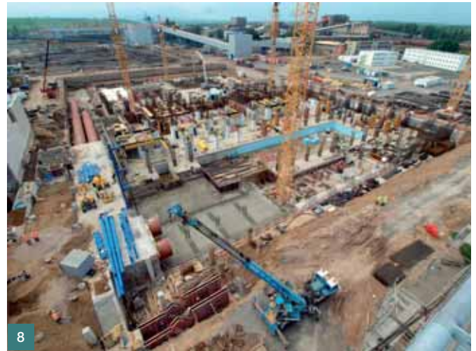
Obr. 7 Část pilotových základů kotelny ■ Fig. 7 Part of piles foundations of the boiler house
