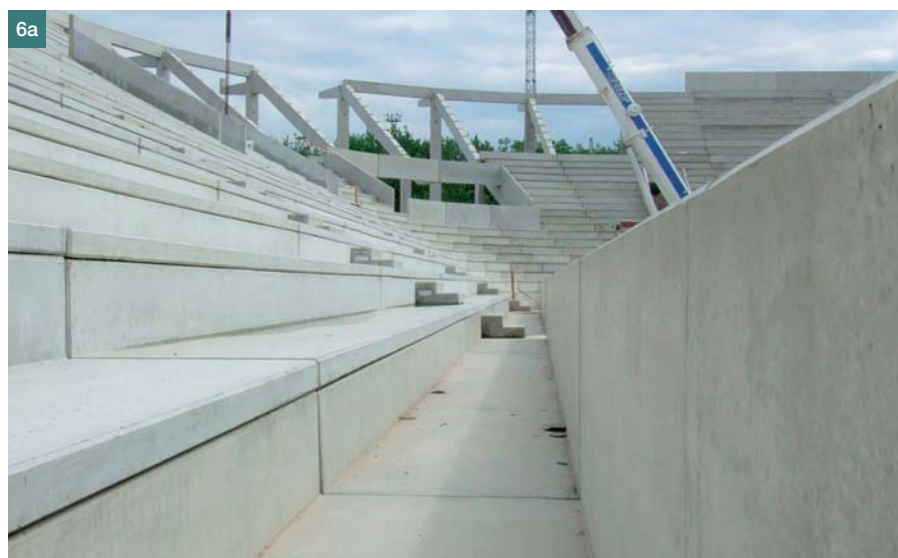
Obr. 6 Ukázka praktických realizací v průběhu posledních let, a) Stadion Eden Praha, LC35/38 D 1,8 XF4 XC4 V5, objemová hmotnost 1 730 kg/m 3 , pevnost v tlaku 47 MPa, statický modul pružnosti 25 GPa, dynamický modul pružnosti 30 GPa, b) Multifunkční stadion Karlovy Vary, LC25/28 D 1,6 XF4 XC4 V5, objemová hmotnost 1 550 kg/m 3 , pevnost v tlaku 34 MPa, statický modul pružnosti 22 GPa ■
