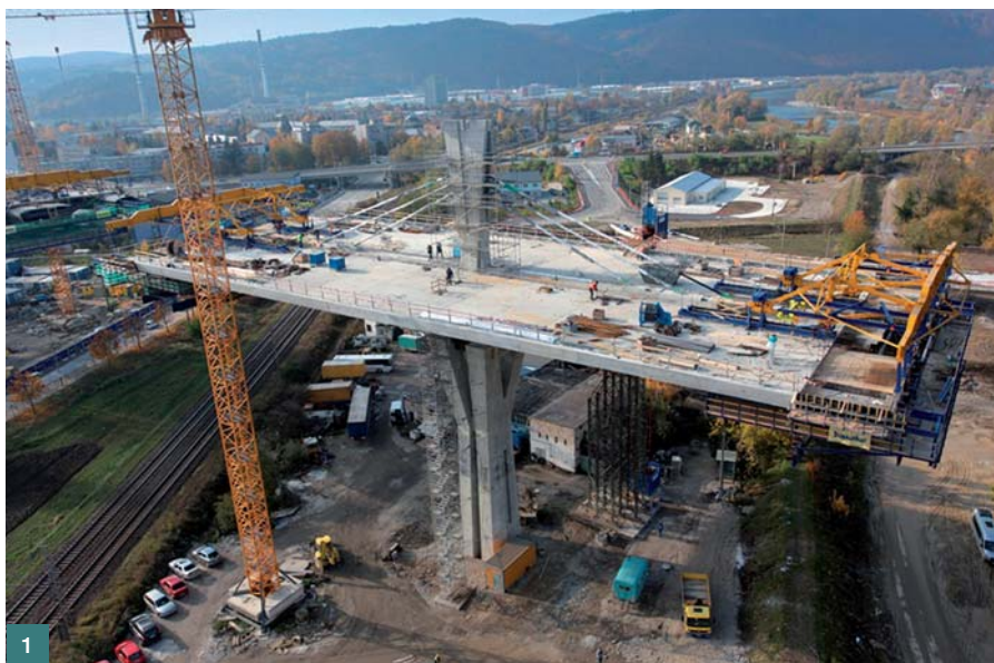
Obr. 1 Výstavba vahadla ■ Fig. 1 Construction of balanced cantilever
