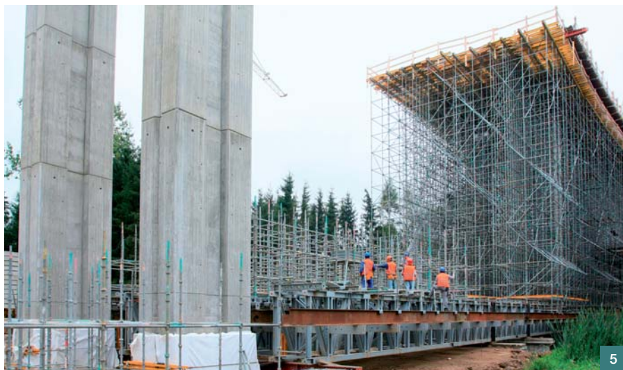
Obr. 5 Zakládání skruže na příhradové konstrukci ■ Fig. 5 Foundation of the scaffolding on trusses
