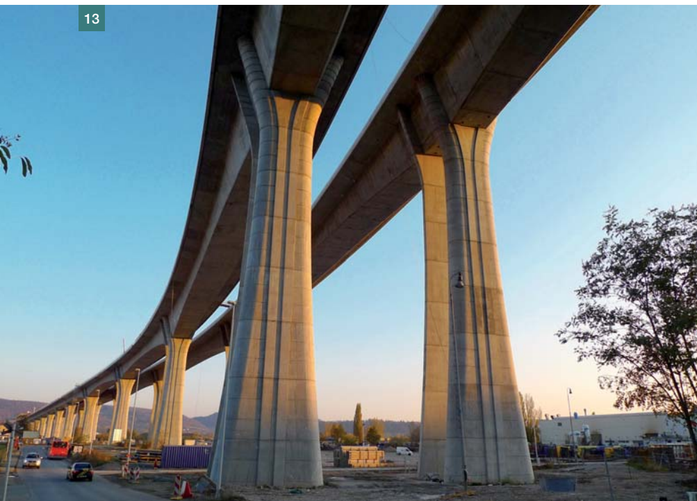
Obr. 13 SO 204/1.4 – pohled na dokončenou mostní estakádu přes údolí Berounky ■ Fig. 13 BO 204 View of the completed bridge over the valley of the Berounka river
