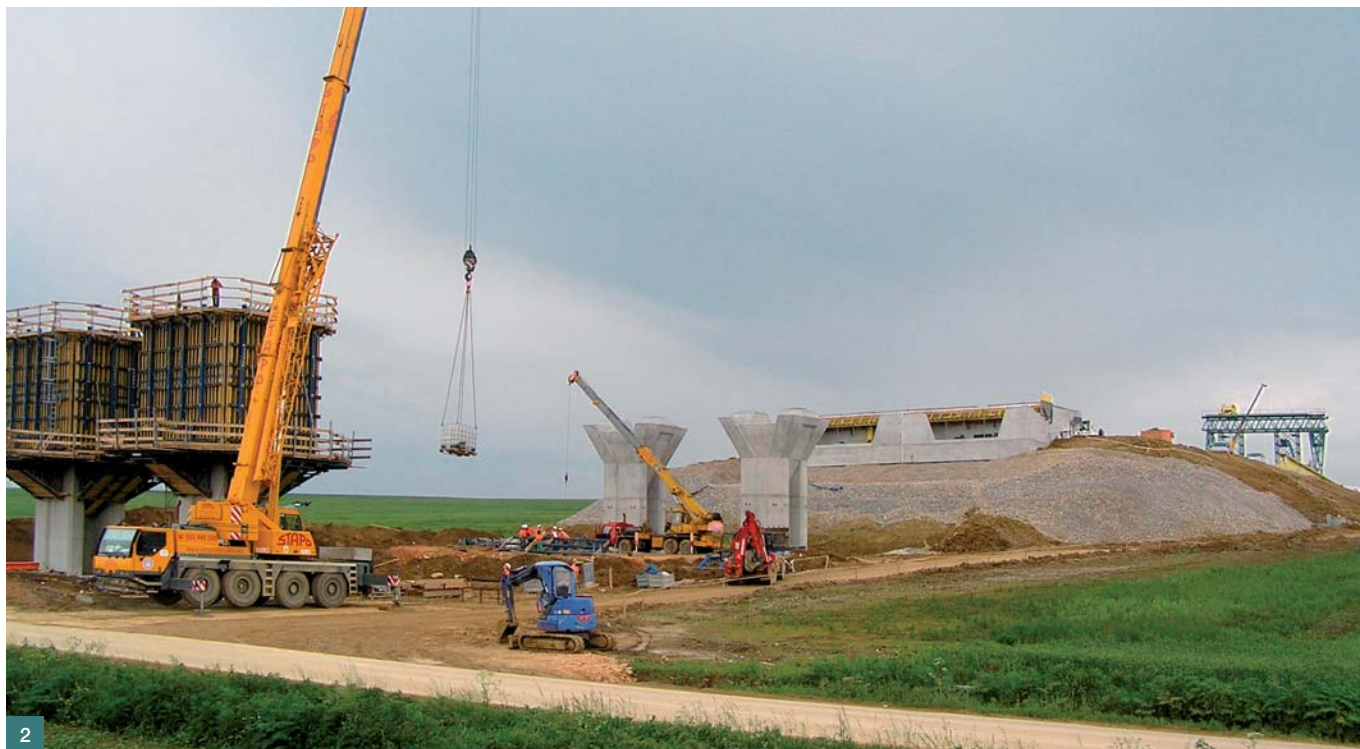
Obr. 1 Segmentový most 203 – pohled směrem na Zvolen ■ Fig. 1 Segment bridge No. 203 – view direction towards the city of Zvolen
