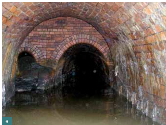
Obr. 5 Technologie injektáže stoky – zděný profil (základní údaje: vnitřní obvod stoky 5,61 m, plocha příčného profilu 2,51 m 2 , materiál: zdivo, celková délka úseku 86,9 m) ■ Fig. 5 Technology of grouting sewer – brick profile (basic information: inner perimeter drains 5.61 m, cross-profile area 2.51 m 2 , material: masonry (brick), total segment length 86.9 m)
