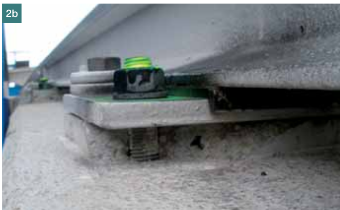
Obr. 2 a) Pohled na přehradní hráz s kolejovou dráhou, b) detail kotvení kolejnice ■
