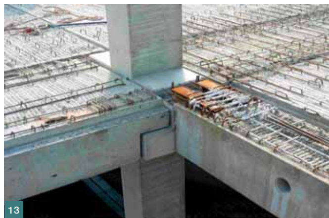
Obr. 14 Montážní otvor v ozubu vazníku ■ Fig. 14 Assembly hole in Gerber truss beam
