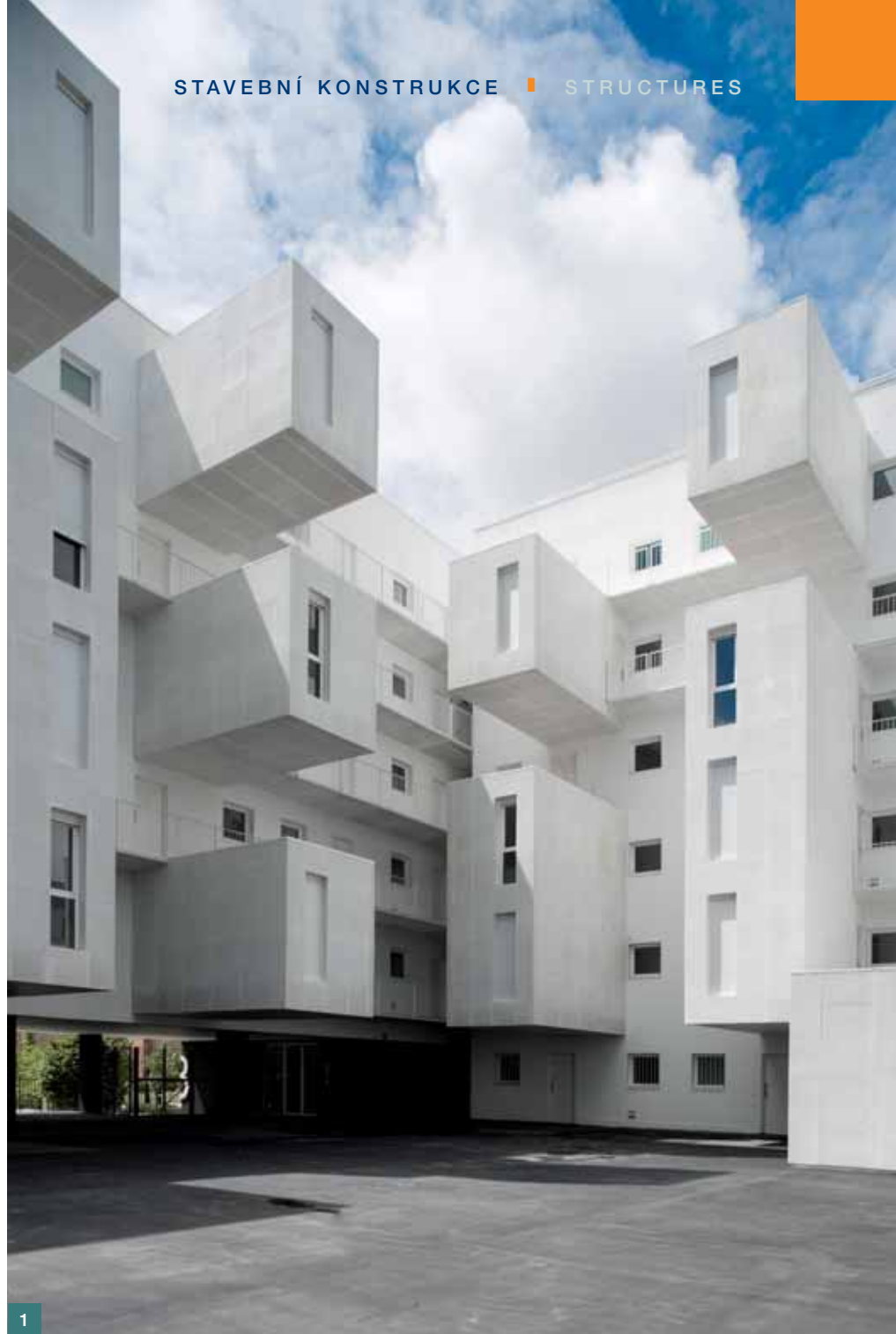
Obr. 1 Dvorní fasády s konzolami „přídavných“ pokojů ■ Fig. 1 Modules of extra-bedrooms attached to the inner facade
