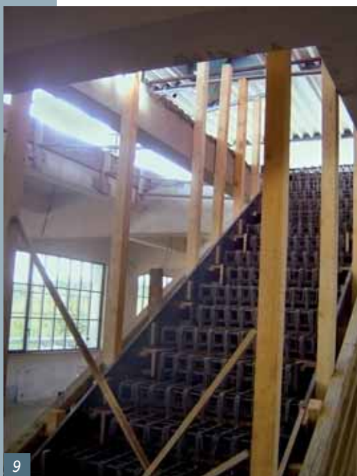
Obr. 9 Bednění s výztuží během provádění (autor Ing. arch. Kubiček)
