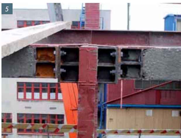
Obr. 4 Montáž ocelové konstrukce, Hala Liberec
