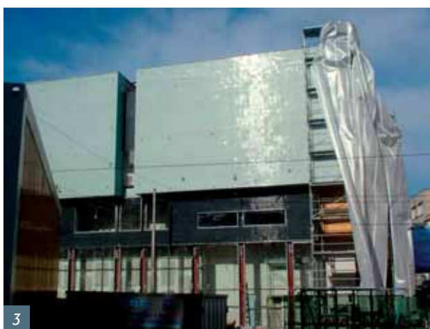
Obr. 1 Ocelobetonová spřažená konstrukce – montáž, Zlaté jablko, Zlín
