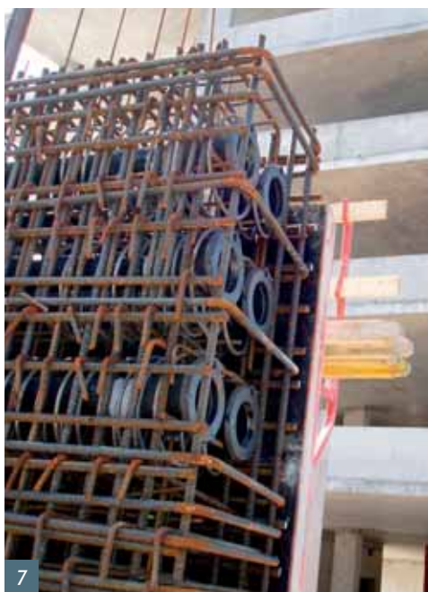
Obr. 7 Kotvy predpínacích káblov Fig. 7 Anchors of tendons
