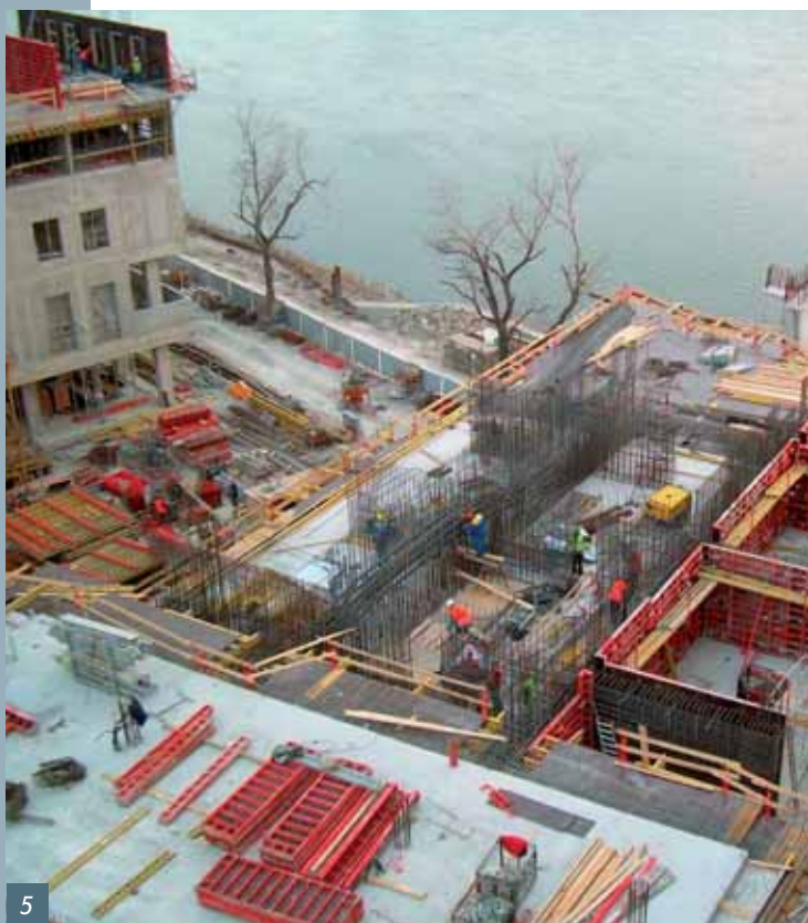
Obr. 5 Pohľad na rozostavanú konštrukciu 1. poschodia (február 2008)
