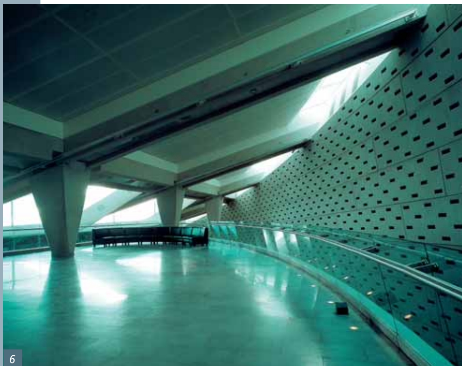
Obr. 6 Horní galerie pod stropem velké čítárny se zvukově pohltivou stěnou z prefabrikovaných betonových panelů
